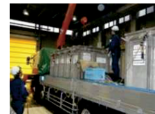
雨天時、強風時受け入れ (屋内...作業棟)
